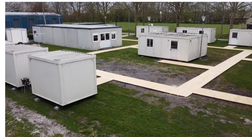
Figuur 2.3: Huidige tijdelijke huisvesting op de Weijver (bron: Google)
