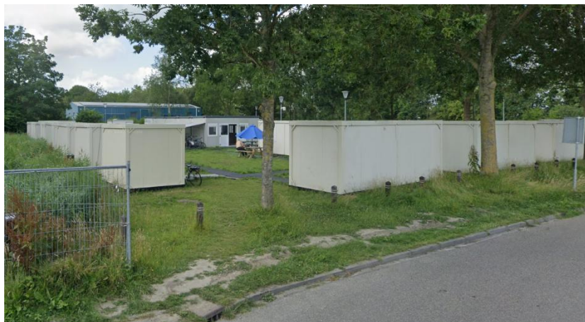
Figuur 2.1: Huidige tijdelijke huisvesting op de Weijver (bron: Google)
