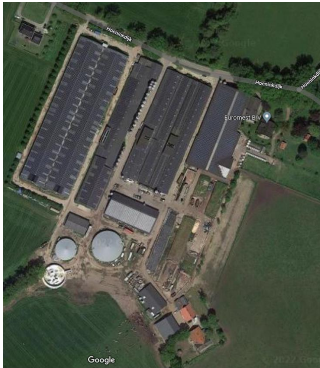
Figuur 4: luchtfoto gerealiseerde en bestaande situatie met ligging mestverwerkingsloods en mest(vergisting)silo's
