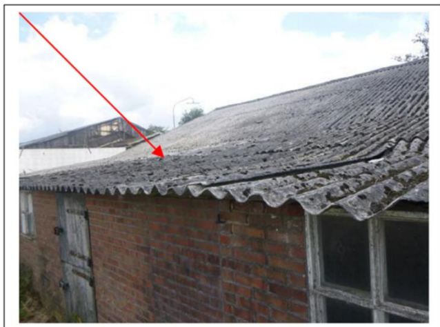
Figuur 9: Dakhelling oorspronkelijke veldschuur
