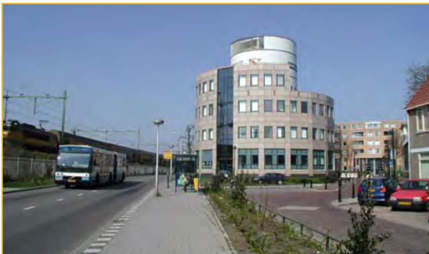
Vaartsestraat en gebouw Burgerzaken
