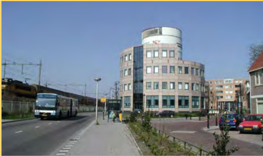
Vaartsestraat en gebouw Burgerzaken
