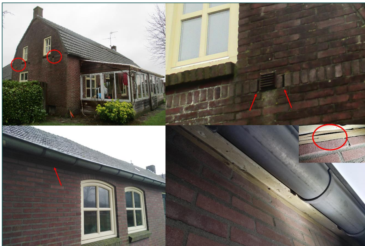
Figuur 3.1 Het woonhuis heeft voor vleermuis toegankelijke openingen aan de kopgevels (bovenste foto's). De westelijke gevel van de aanbouw heeft enkele openingen onder de dakgoot waardoor vleermuizen de spouwruimte kunnen bereiken (onderste foto's).
