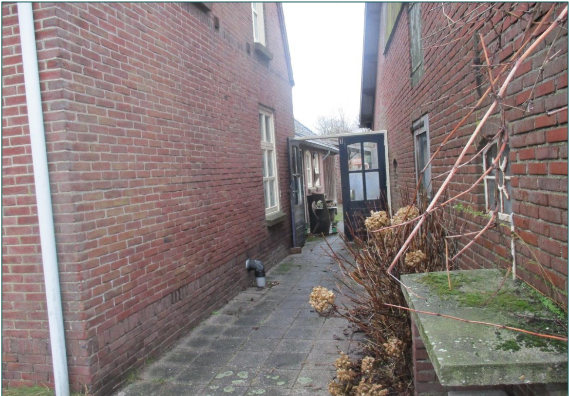
Figuur 4 Links de woning (1) en rechts de grote schuur (2).
