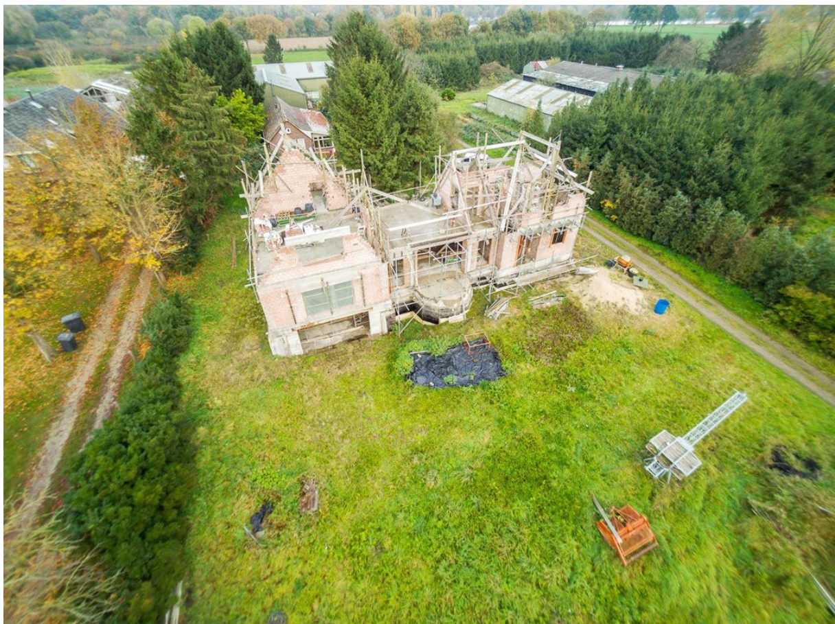
het in aanbouw zijnde pand
