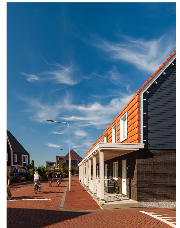
veranda langs langskap
