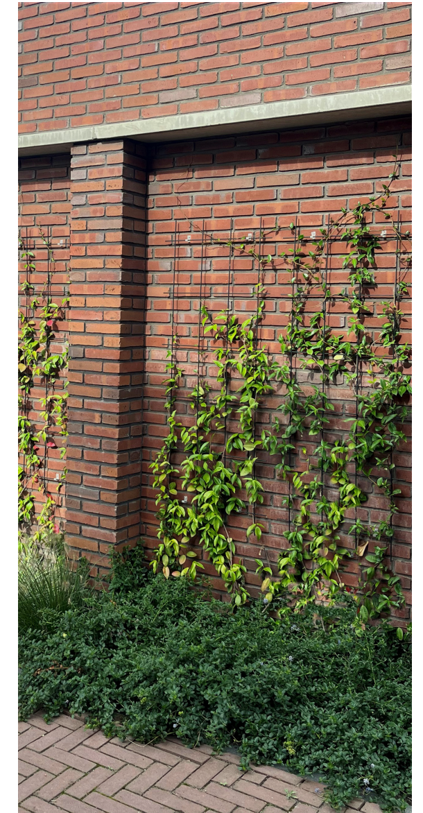
doortekening en plekbeplating dmv penanten
