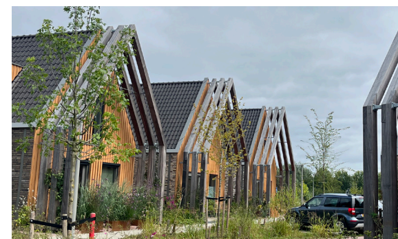
overgang zone onder pergola in kapvorm
