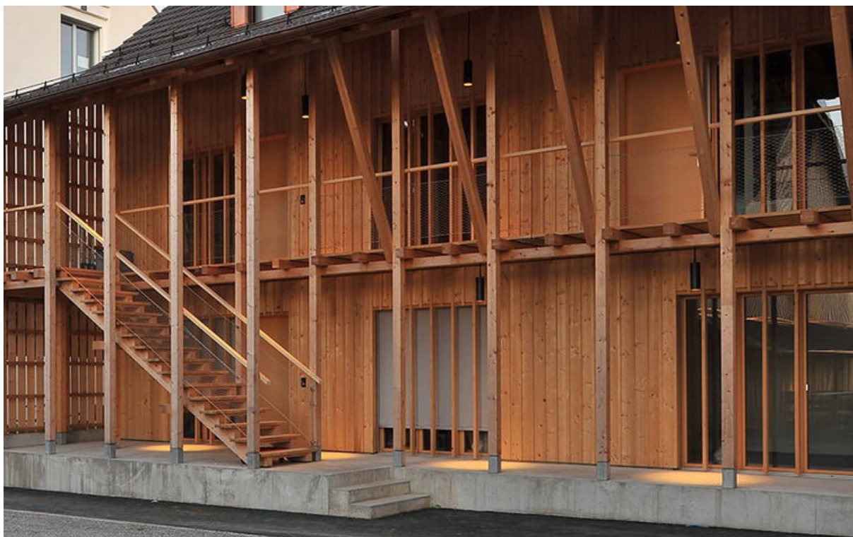
buitenruimtes onder galerij aan de openbare ruimte op verhoging
