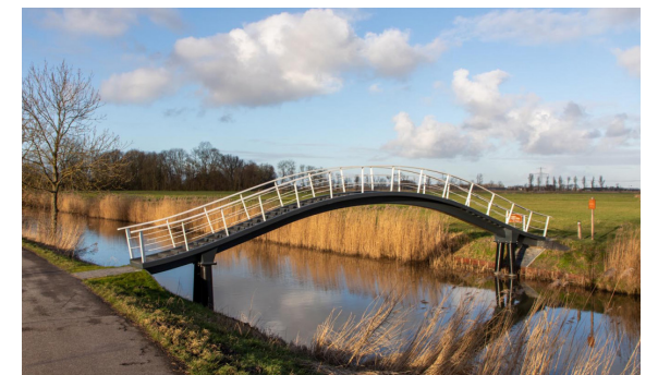
voorbeeld eenvoudige voetgangersbrug
