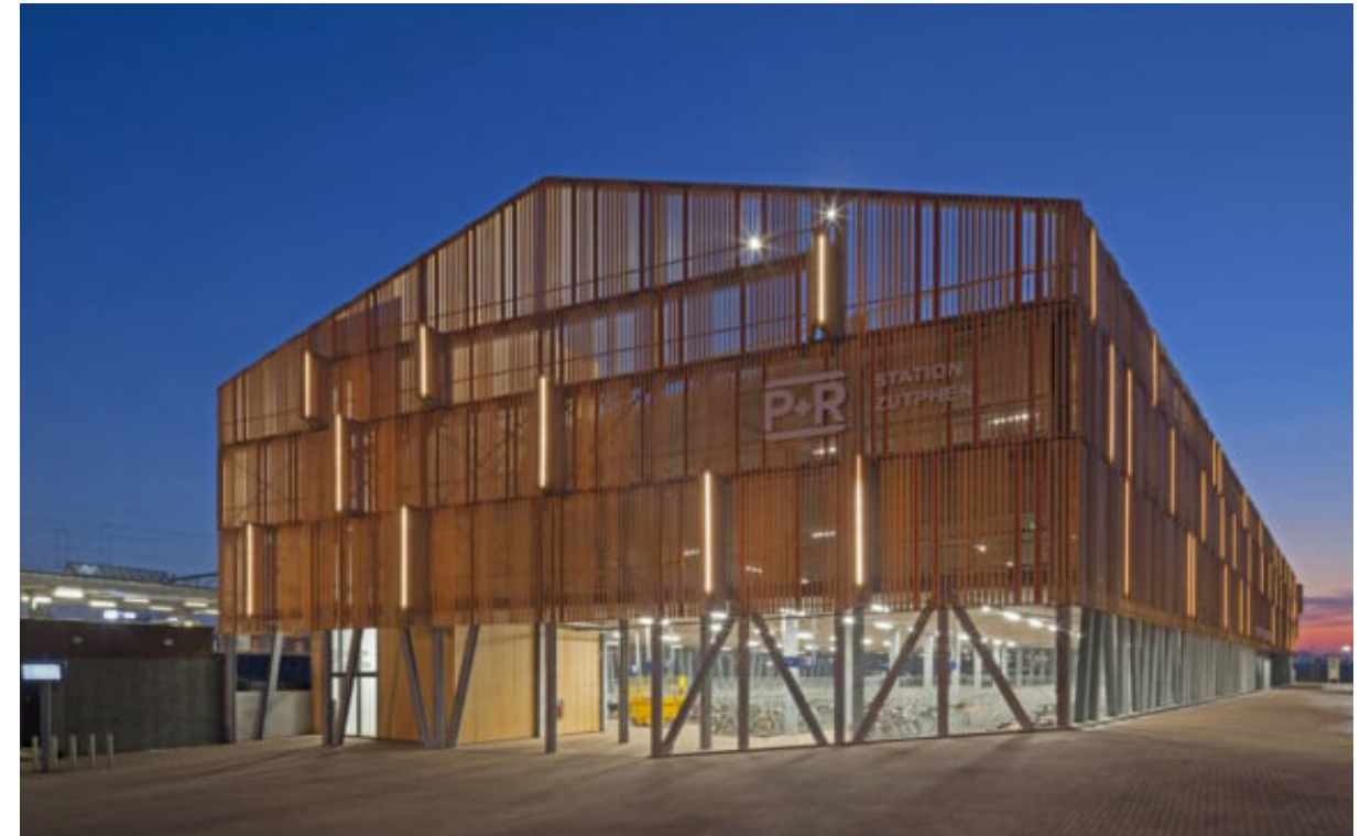
houten gevels op systeembouw met "kapvorm front" en zorgvuldig mee-ontworpen verlichting
