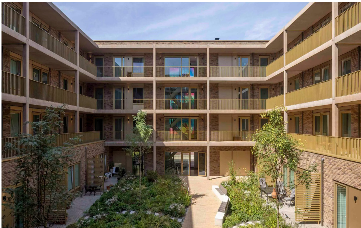
aantrekkelijk en zorgvuldig vormgegeven galerijen
