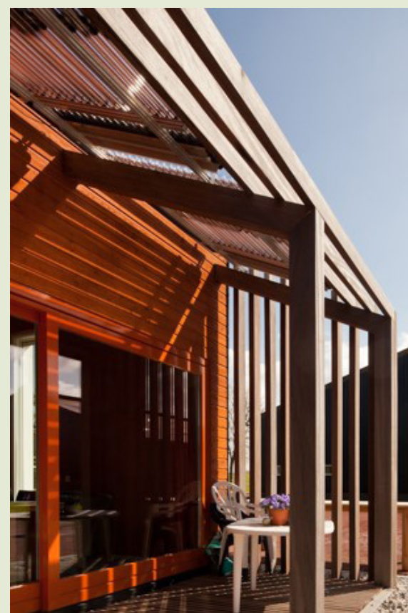
rekening houden met passieve maatregelen zoals grote opening op zuid en schaduw
