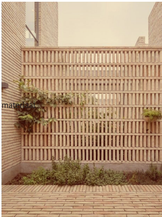
gevelmateriaal doortrekken met braziliaans metselwerk
