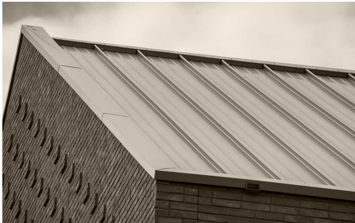
krachtige vormen door strakke dakranden
