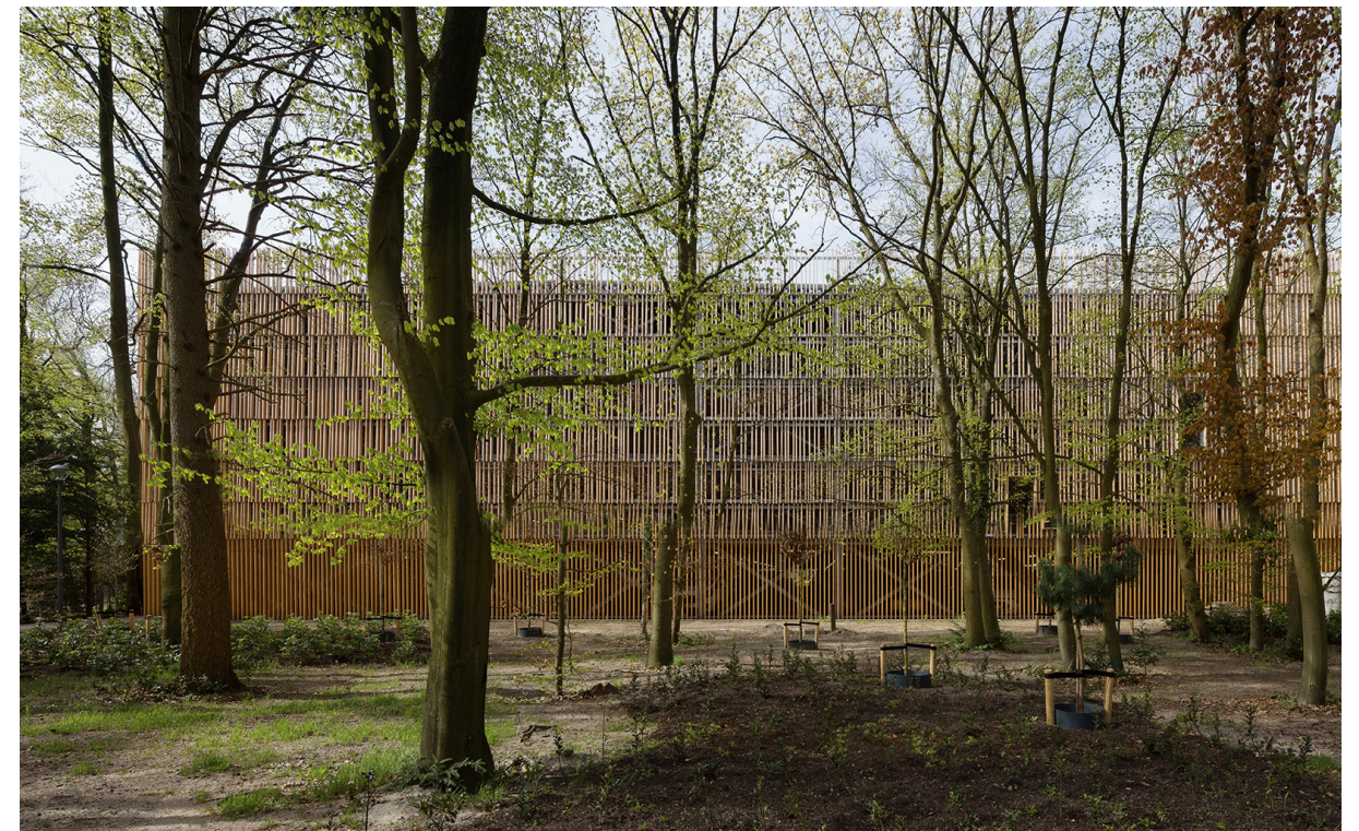
houten gevel op systeembouw passend in de omgeving
