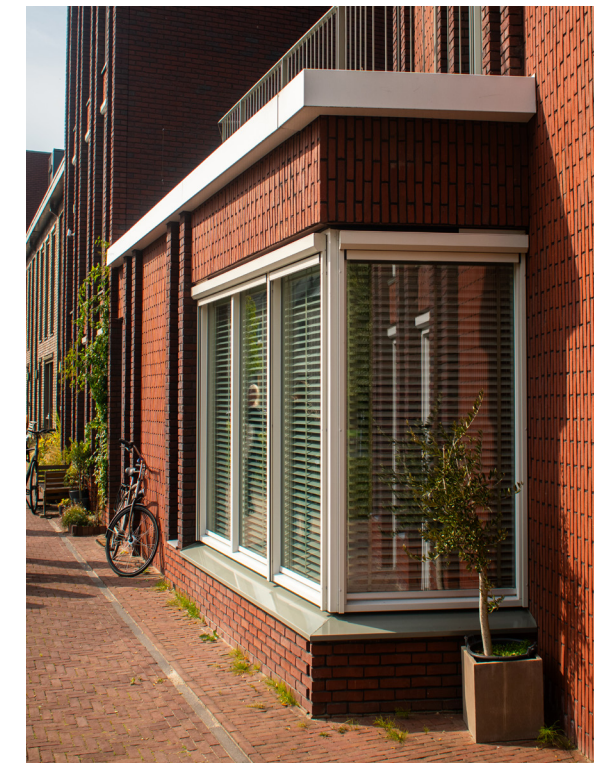
terugkijkraam in erker uitbouw
