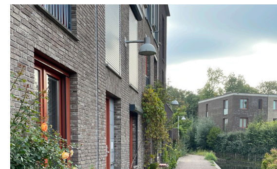
voorbeeld verlichting aan de gevel
