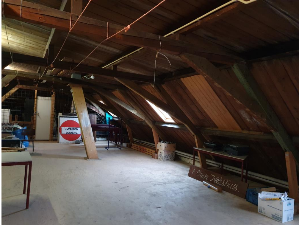
Overzicht van de zolder van het hoofgebouw, 2022.
