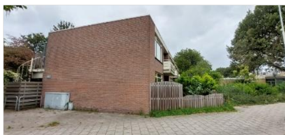
Figuur 2.4 Appartementencomplex (Oostergo 37-51).
