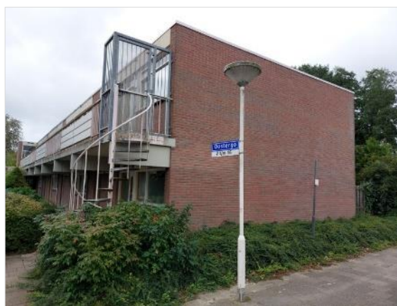
Figuur 2.3 Appartementencomplex (Oostergo 2-16).
