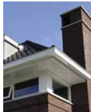
V omtimmerde dakgoten
