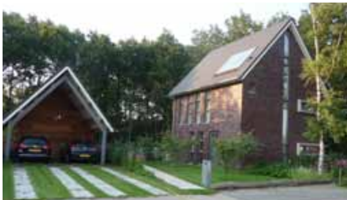
Garage in zelfde stijl en met zelfde dakhelling als woonhuis
