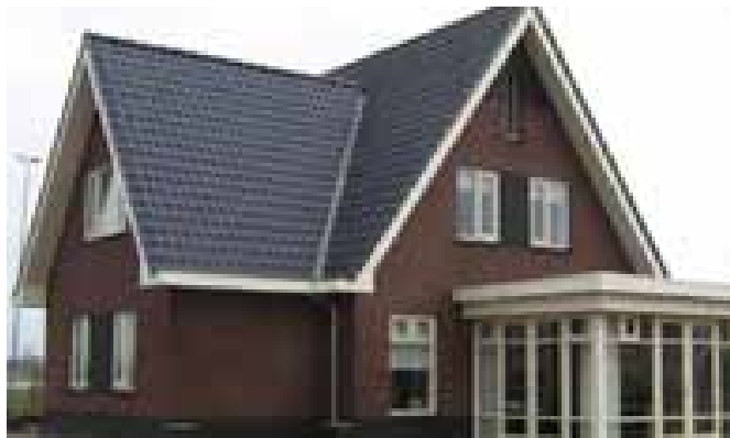
Twee dakrichtingen op de hoek, verbijzondering door erker
