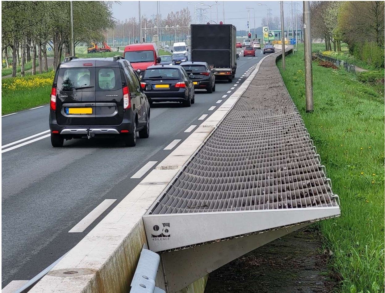
Afbeelding 12: Diffractor om het geluid af te buigen
