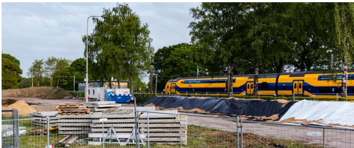
Afbeelding 13: Bouwplaats naast de spoorrails. Een trillingsgevoelige locatie
