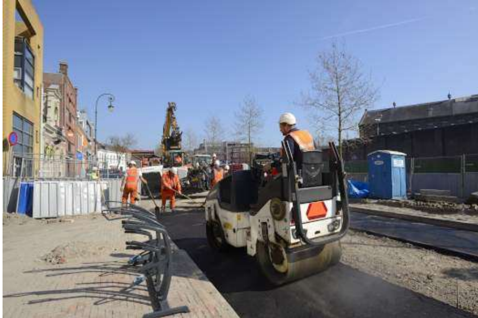
Afbeelding 2: Aanleg asfalt
