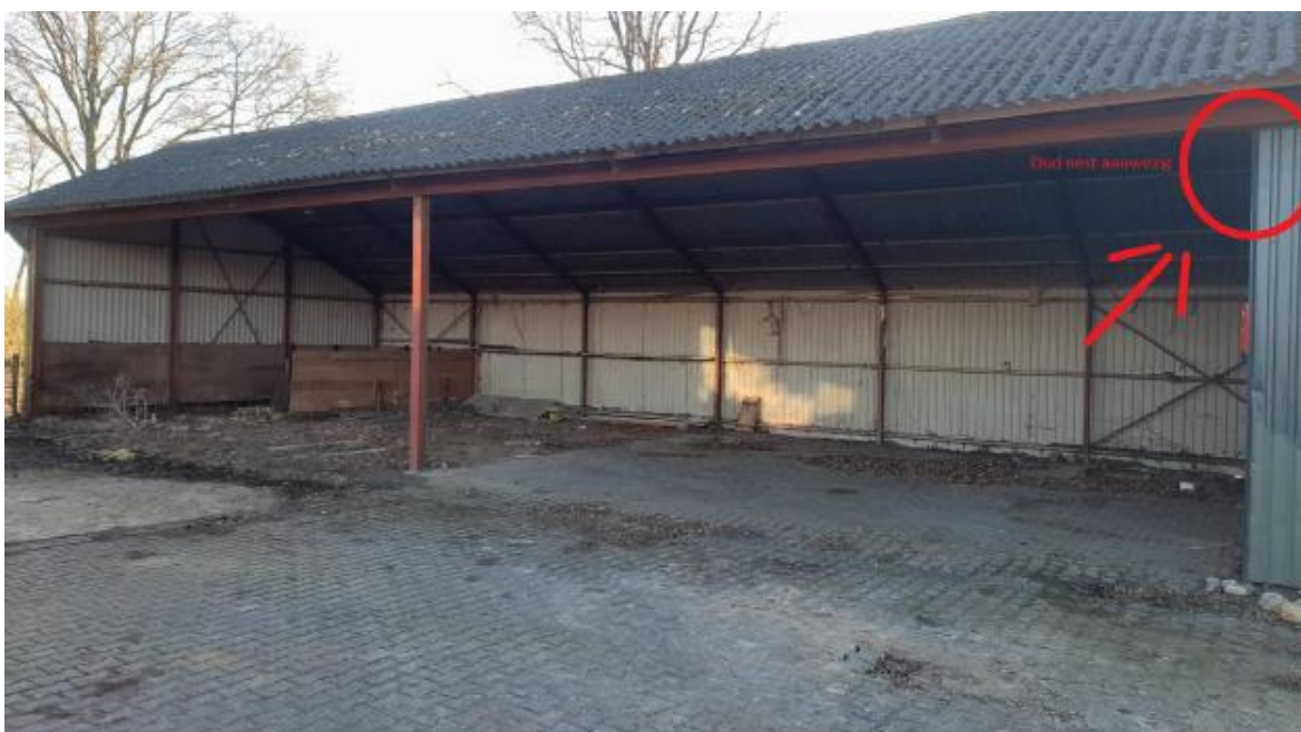
Figuur 6: Locatie in de schuur van het nest
