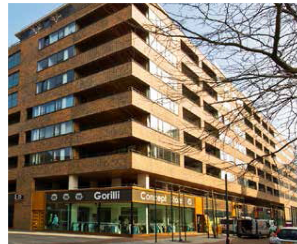
Open parkeerlaag boven de plint, zorgvuldig opgenomen in architectuur van de gehele gevel en daardoor nauwelijks opvalt. Hofdame - Klunder Architecten
