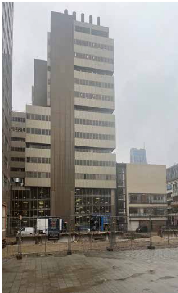
Parkeergarage in bouwblok in de onderbouw van een toren opgelost, bereikbaar en zichtbaar in de (expeditie)straat. Rotterdam Building- Kraaijvanger Architects
