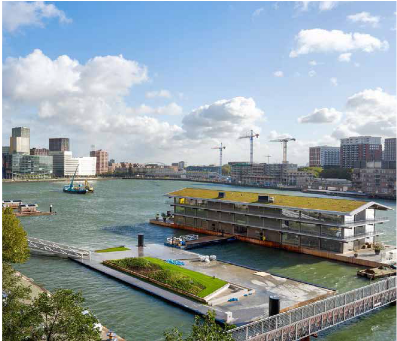
1e fase drijvend park in aanleg & Floating Office Rotterdam
