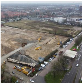
Merwedekanaalzone: Faciliterend grondbeleid
