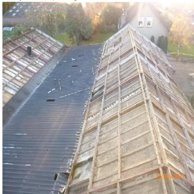
Verwijderde toepassing met asbestvrij dak,
