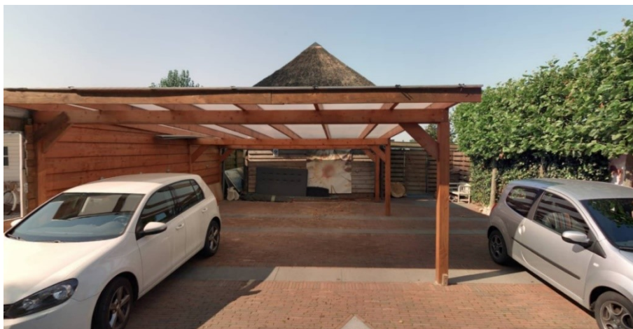
Figuur 1: de bestaande carport met kapberg op het perceel, kadastraal bekend gemeente Ter Aar, sectie b, nummer 4480. Deze bebouwing wordt verwijderd. Het voorste deel van het perceel verkrijgt een woonbestemming met de bouwmogelijkheid voor één woning. Het achterste deel van het perceel blijft bestemd als 'Tuin' en zal als tuin bij de te realiseren woning gaan behoren.
