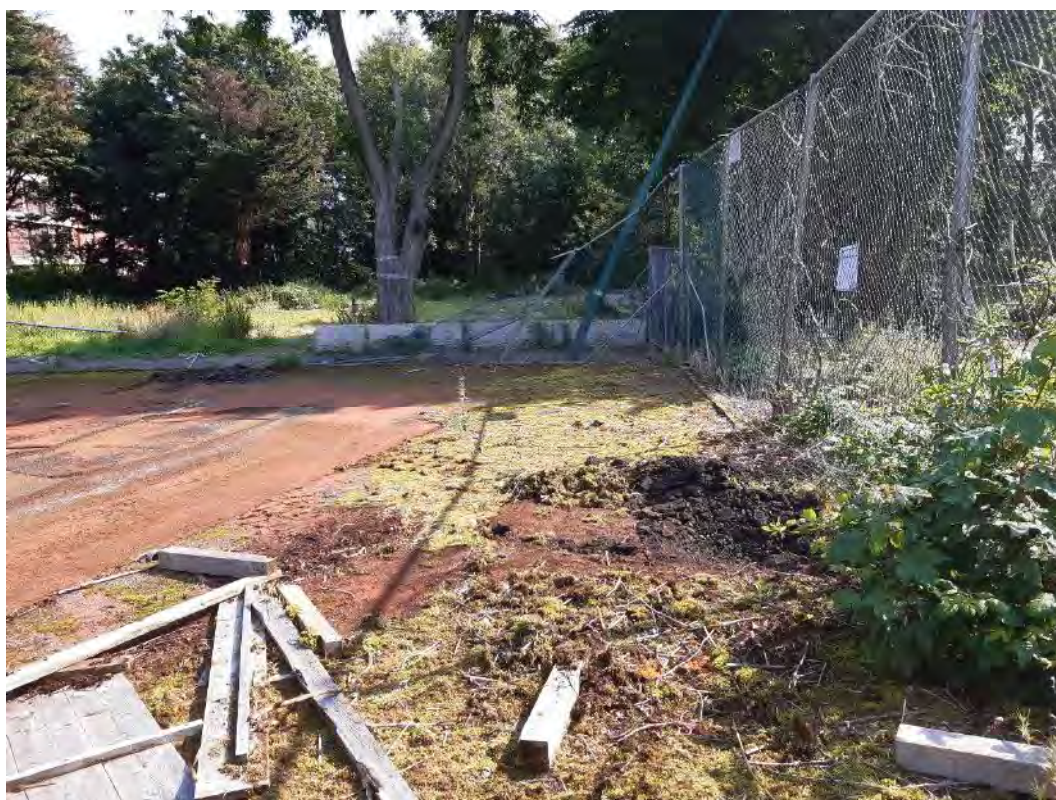
Foto 6: Deellocatie 100, gezien in oostelijke richting
