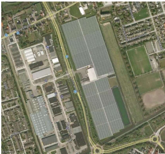
Luchtfoto Google Earth 2006 Figuur 1.1 Ligging plangebied
