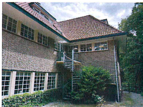
Foto 03 aanzicht zijkant met balkon
