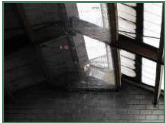
Gaas in de nok van de rundveestal
