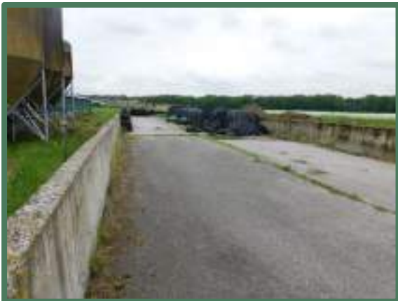
Overzicht te slopen sleufsilo
