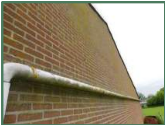
Kopgevel te slopen deel van de loods
