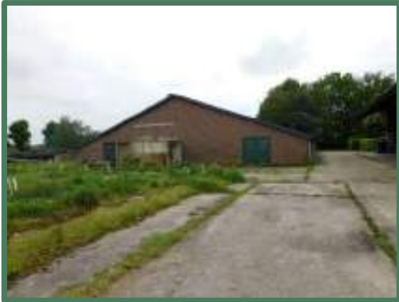
Overzicht te slopen rundveestal vanuit noord
