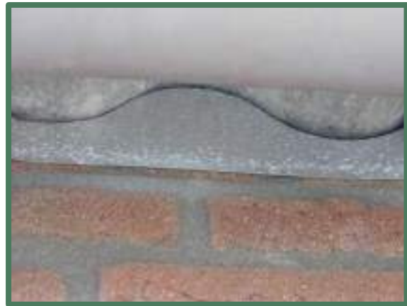
Muurplaat tussen golfplaten en wand
