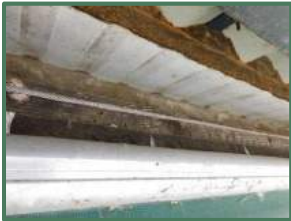
Muurplaat bij sandwichpanelen
