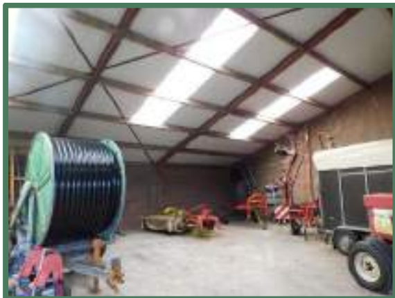
Binnenzijde te slopen loods
