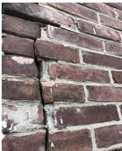
Foto 21 + 22 Zettingsscheuren.
