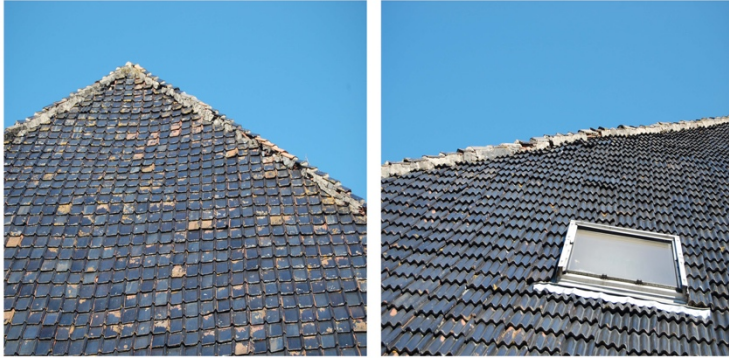
Foto 33 + 34 Nokvorsten van het dak.
