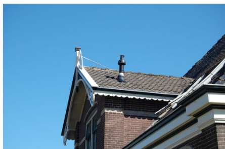
Foto 39 Dakdoorvoer CV.
