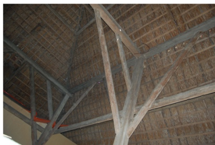
Foto 9 Dubbelvierkant constructie
