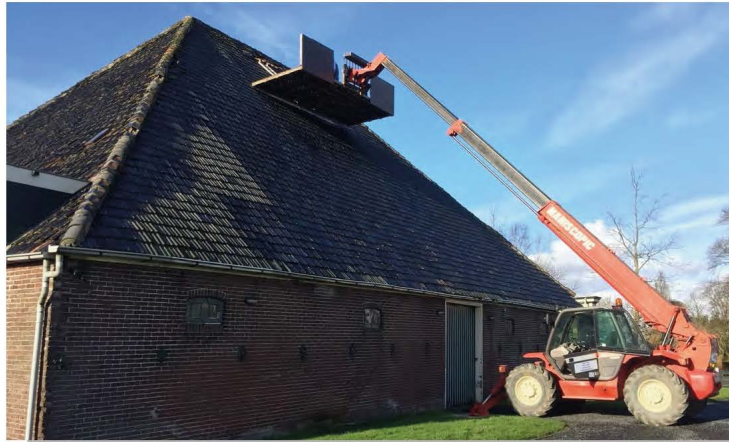
Bouwkundige inspectie medio 2000
