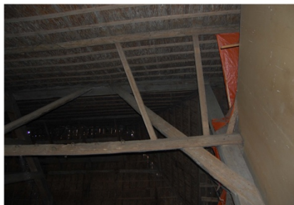
Foto 11 Dubbelvierkant constructie
