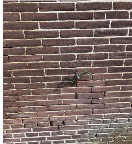
Foto 16 Gedelamineerd metselwerk.
