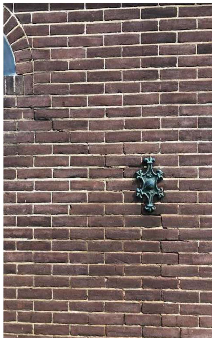
Foto 23 + 24 Zettingsscheuren
