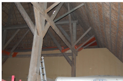
Foto 8 Dubbelvierkant constructie
