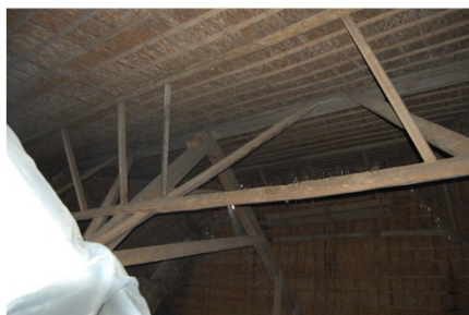
Foto 10 Dubbelvierkant constructie
