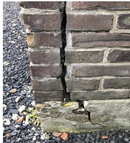
Foto 16 Gedelamineerd metselwerk.
