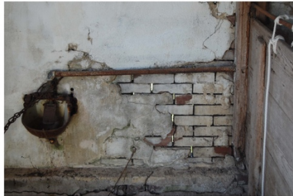
Foto 14 + 15 Gedelamineerd metselwerk.
