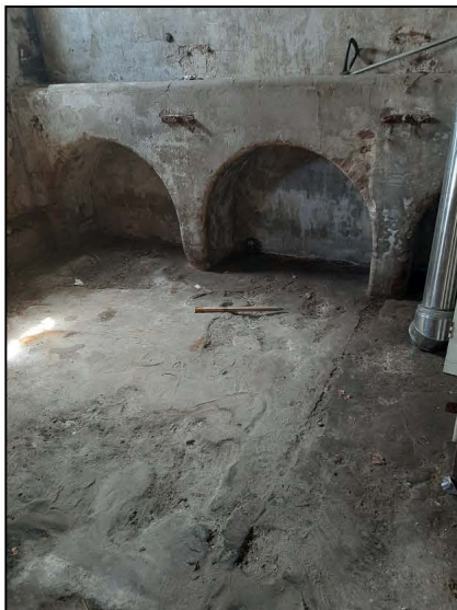
Afbeelding 2.2. Plaatsing camera in erker.
