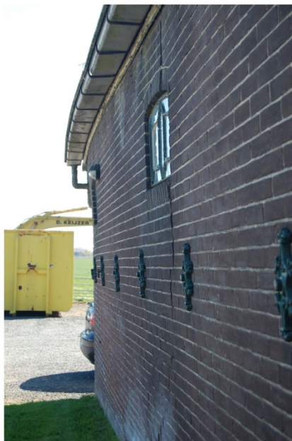
Foto 19 +20 Gevels wijken uit door krachten/zetting van kap.
