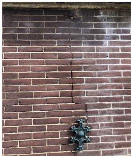
Foto 19 +20 Gevels wijken uit door krachten/zetting van kap.
