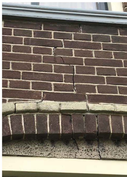
Foto 25 Zettingsscheuren voorgevel
