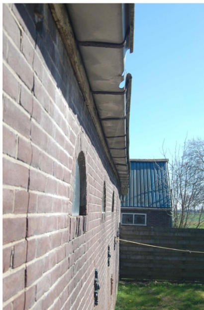
Foto 19 +20 Gevels wijken uit door krachten/zetting van kap.
