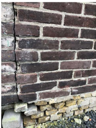
Foto 12 + 13 Gedelamineerd metselwerk.
