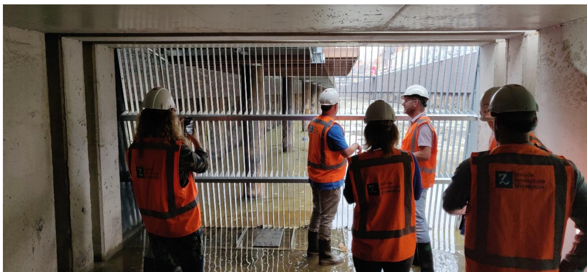
Duiker en instroomvoorziening zuidzijde van het project
