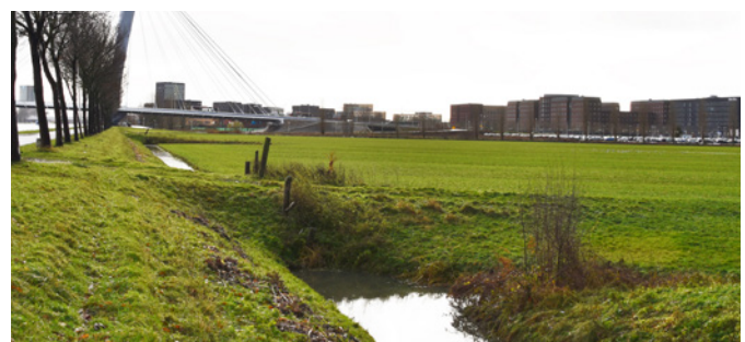
bestaande constructie dijkverbindingen
