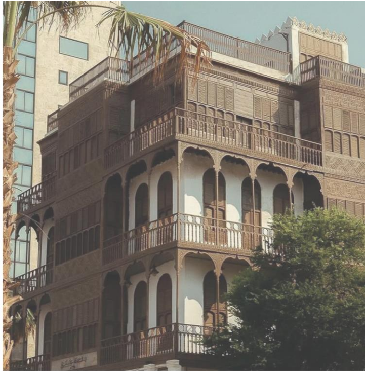
Referentie Oude centrum Jeddah, Saudi-Arabie -> bogen in constructie voor het gebouw
