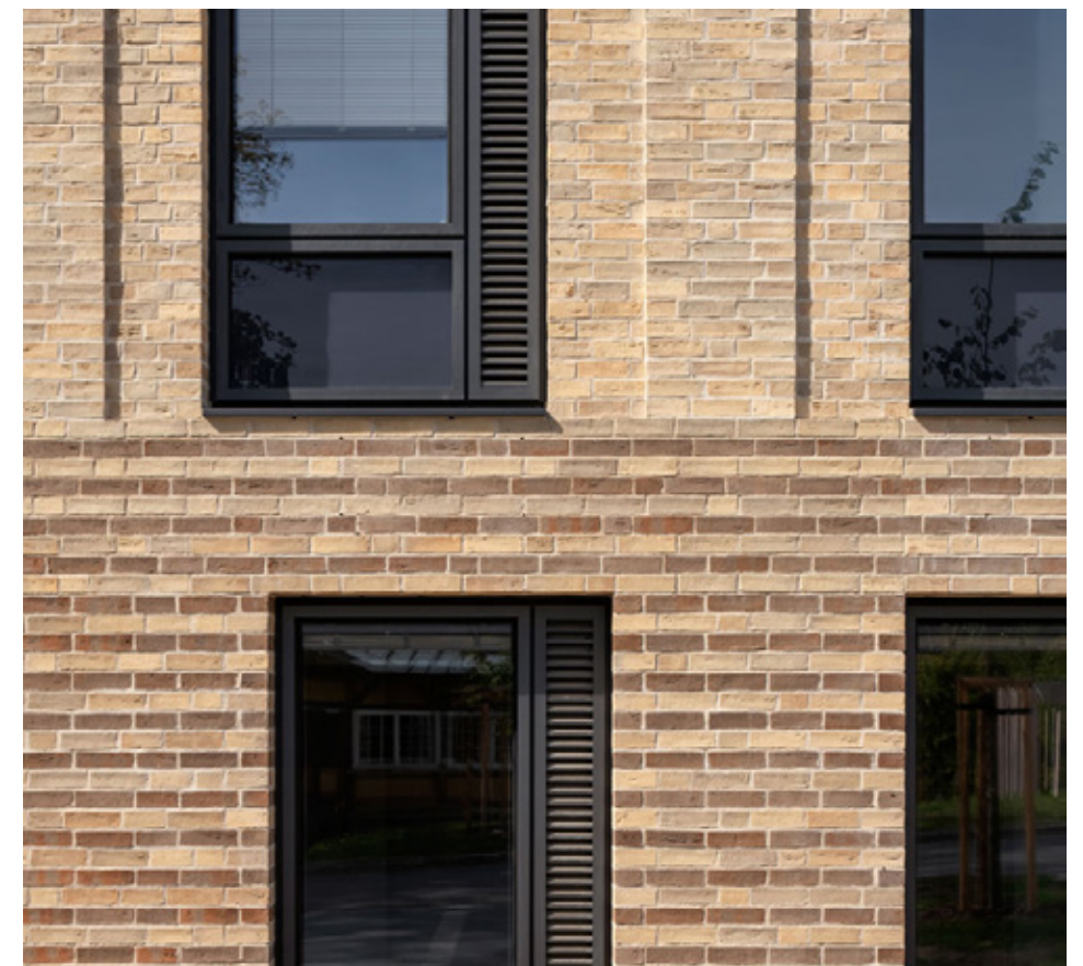
Onder: reliëf en variatie in metselwerk
