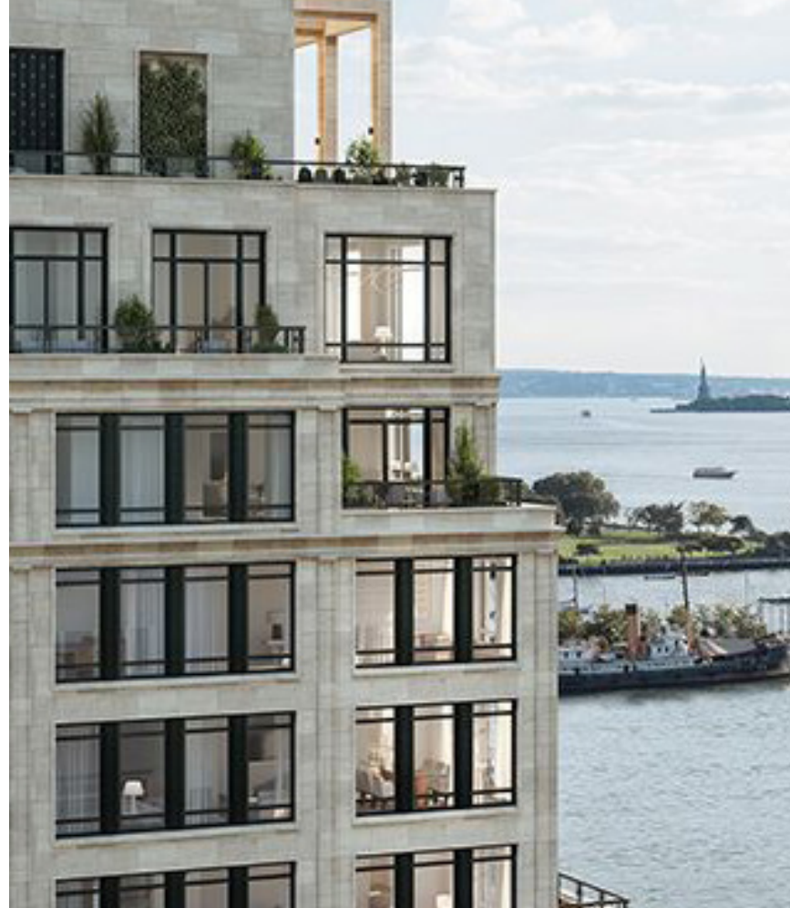
Boven: gevarieerde gevelpartijen in combinatie met groene buitenruimten
