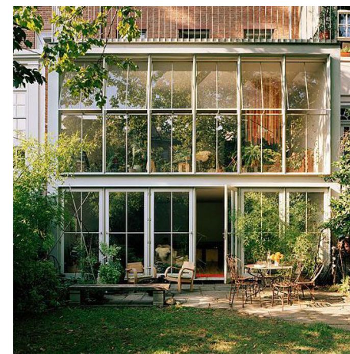
Grote puien met openslaande deuren op de begane grond
