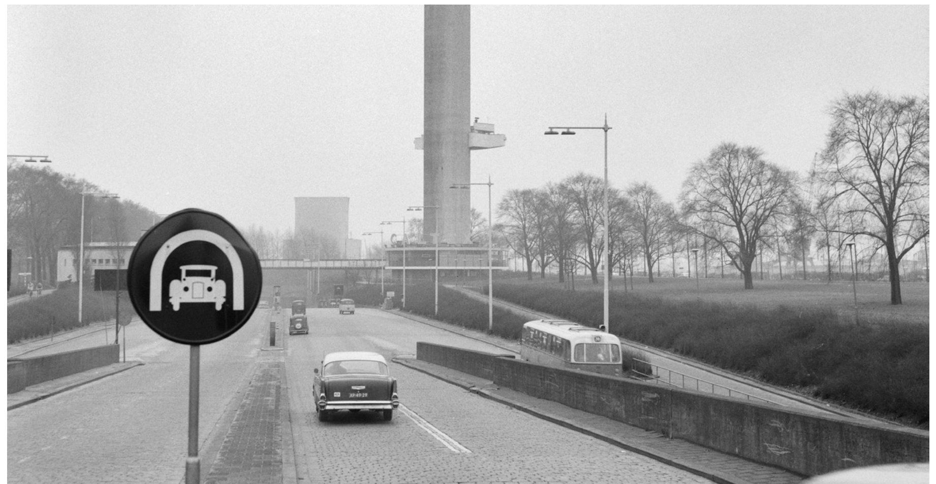
Het Maastunnelcomplex vanaf het Droogleever Fortuynplein
