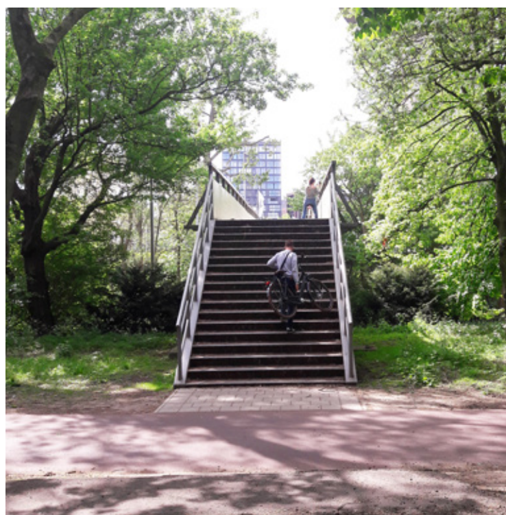
Foto van de huidige brug
