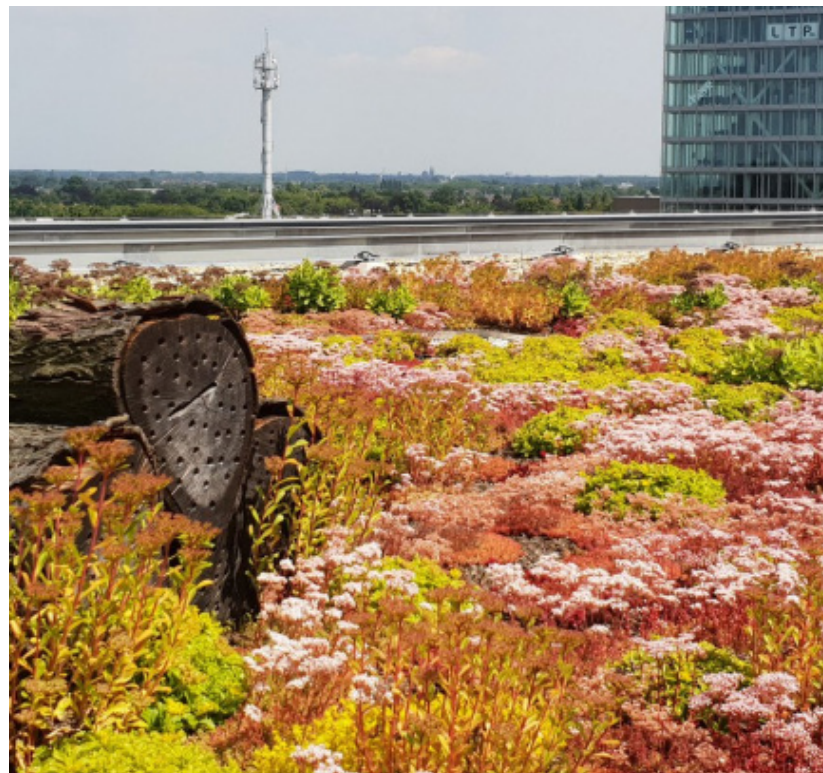
Extensief groen dak met sedum en grassen
