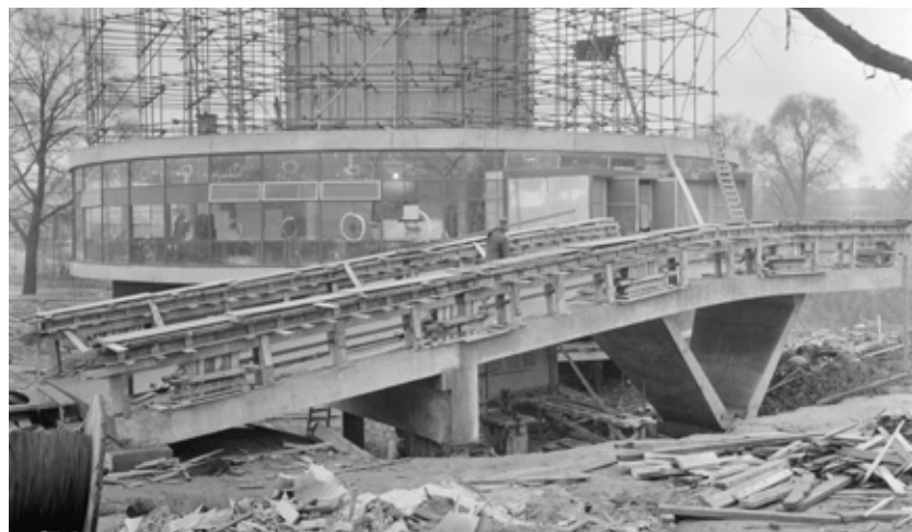
Aanbouw van bestaande overbrugging
