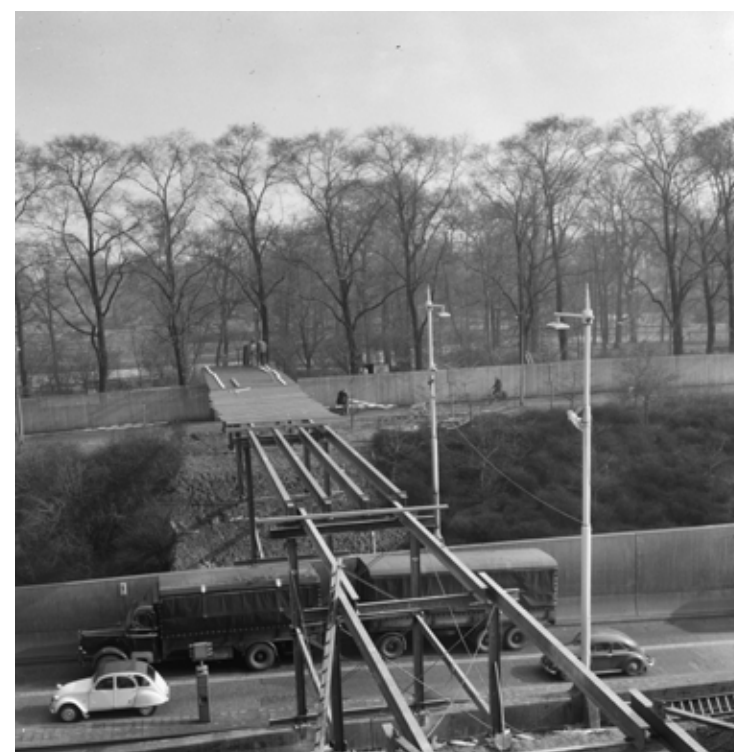
De opbouw van de brug
