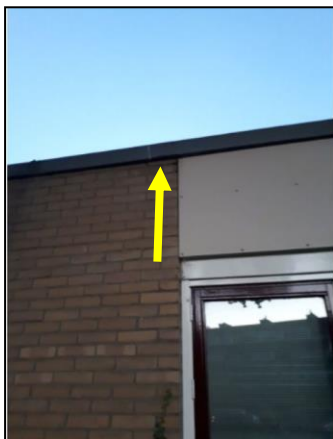
Figuur 7. Invlieglocatie gewone dwergvleermuis onder daklijst van Prins Clauslaan 10 net buiten de onderzoekslocatie.
