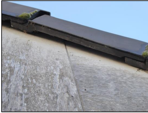
Ruimte onder de dakpannen en open stootvoegen.
