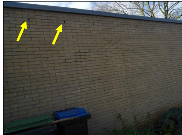
Figuur 11. Open stootvoegen bieden toegang tot luchtsponw voor vleermuizen.
