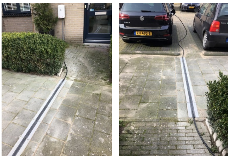
Figuur 3 – EV Kabelgoot Tegel door trottoir (Bron: Struyk Verwo Infra)
