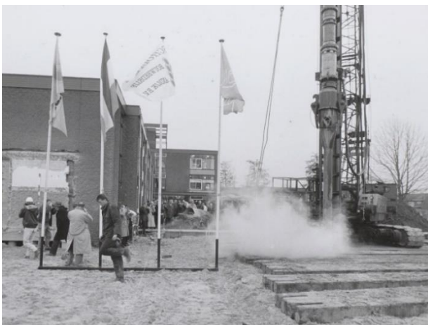
Heiwerkzaamheden voor de uitbreiding aan de noordvleugel, foto 1994.
