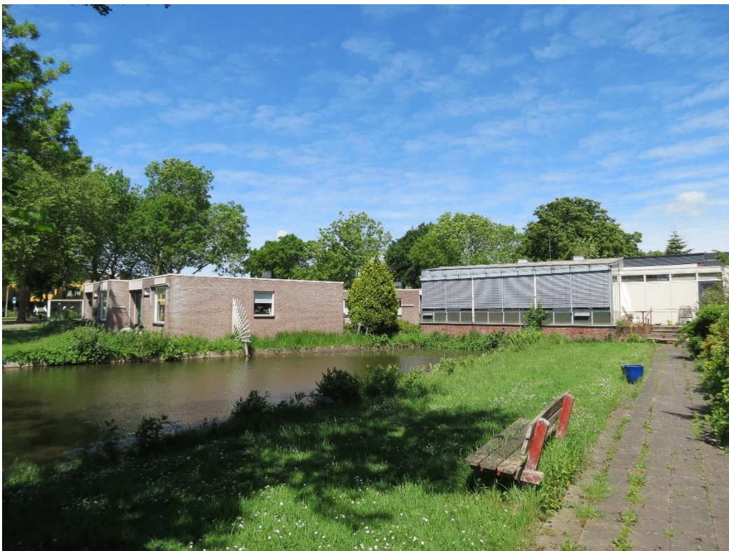
Afb.2. Westvleugel, zuidzijde, met links de later aangebouwde zorgwoningen en rechts de recreatiezaal.
