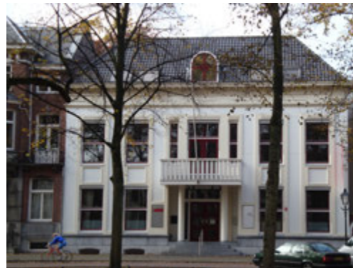
Restauratie/renovatie wanden binnen de vormtaal bebouwing Maliebaan
