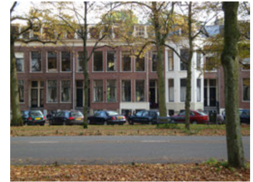
Pandsgewijze stroken bebouwing aan de Maliebaan.
