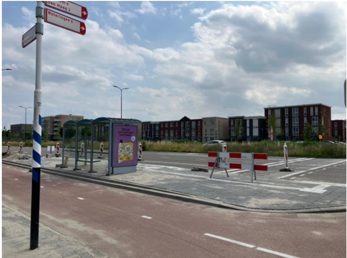
Aanleg bushalte RijswijkBuiten
