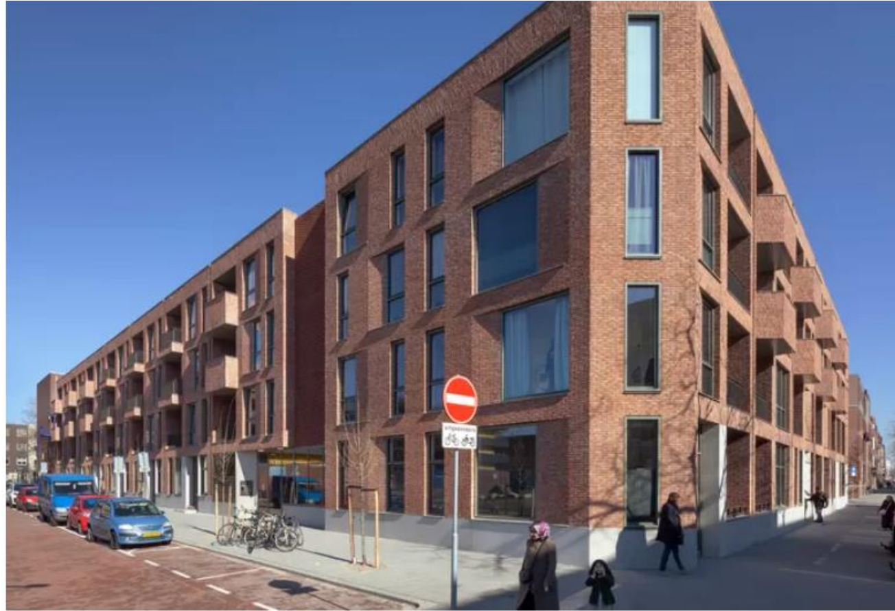
▲ Malieklos, het project in Hillesluis. © Woonstad
