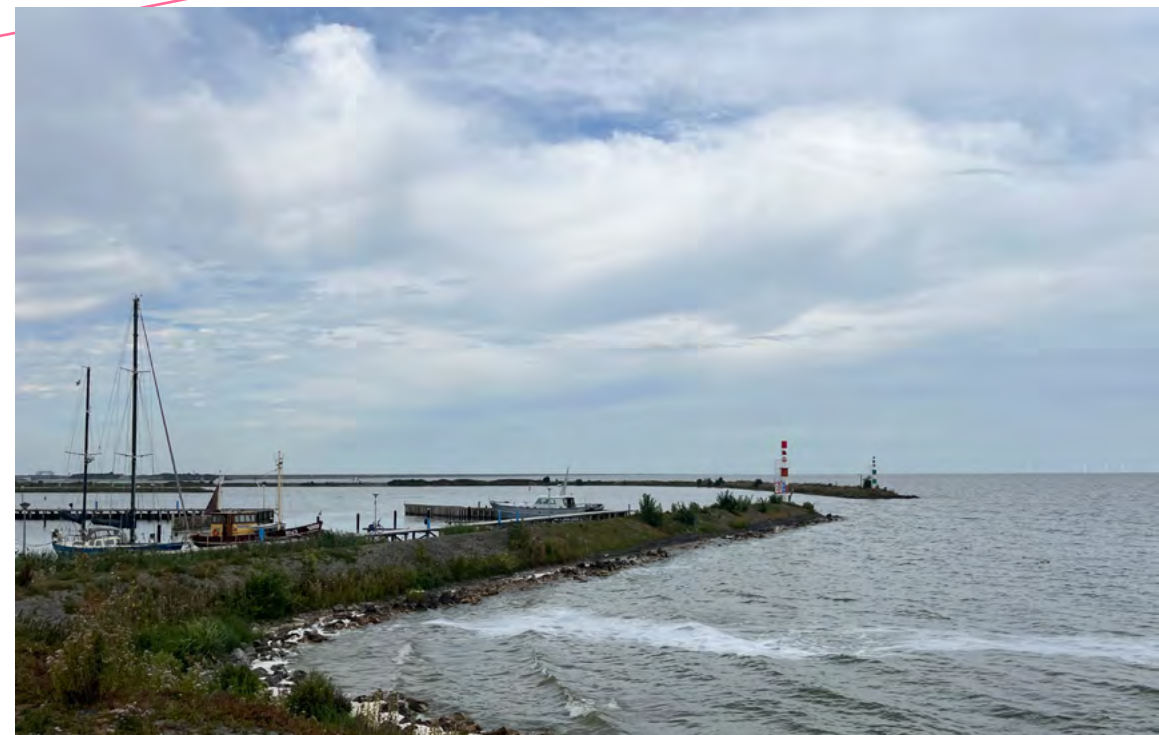
Kijkend richting de Afsluitdijk
