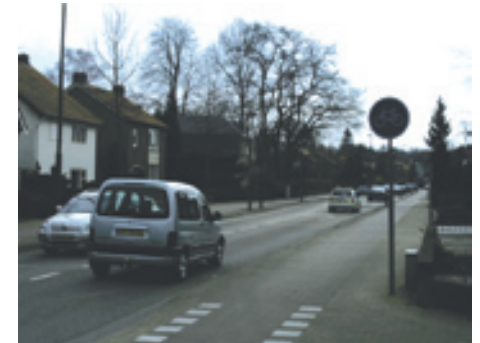
In bepaalde gevallen ontbreekt voldoende ondergrondse ruimte
