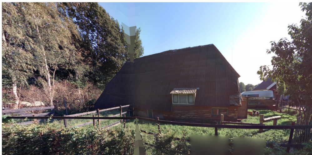
Voormalige bebouwing perceel Lage Enkweg, naast nummer 16
