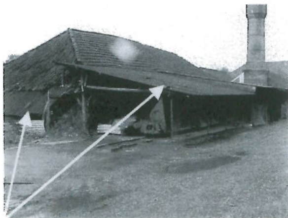
Afbeelding 5: 2 (Gebouw B/Golfplaten op overkapping)
