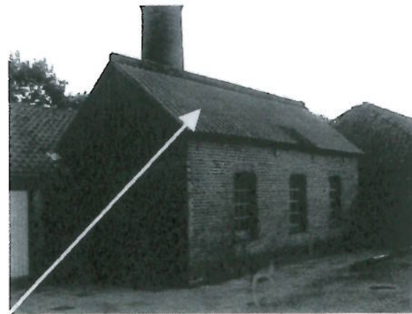
Afbeelding 6: 3 (Gebouw B/Golfplaten op garage)
