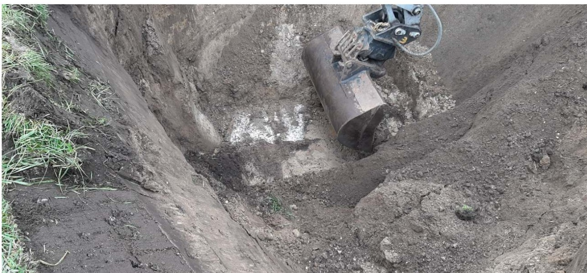
Figuur 3: Eén van de oude betonnen funderingen.
