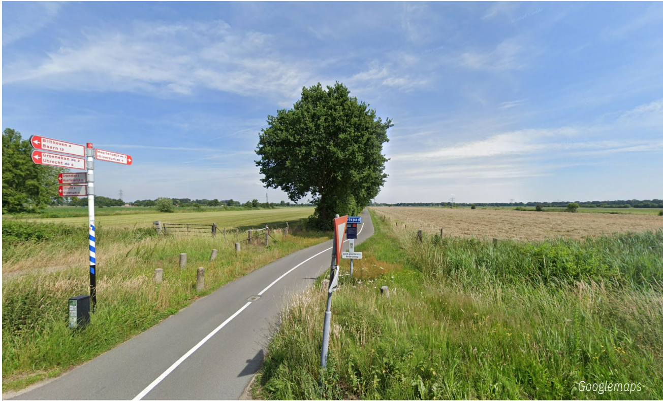
Oostveense Pad | vrijliggend fietspad tussen Groenekan en Maartensdijk
