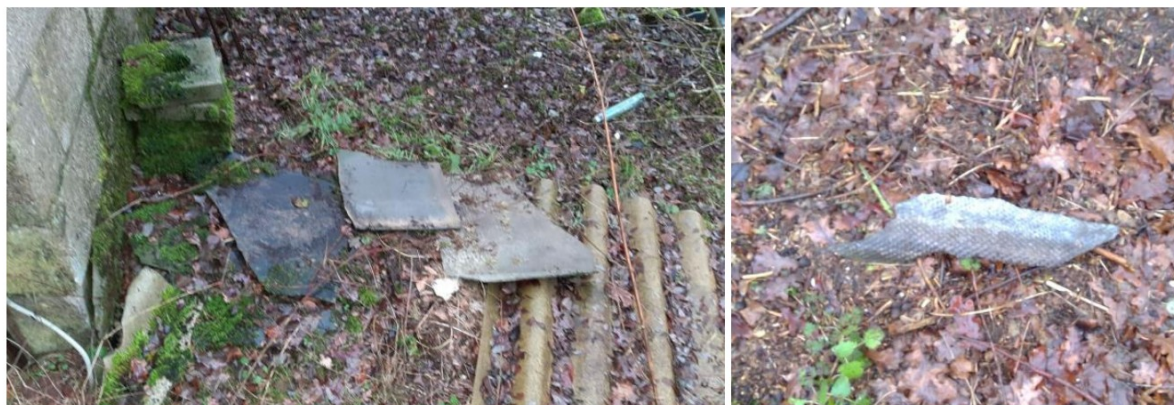
foto's: aangetroffen stukken asbest
