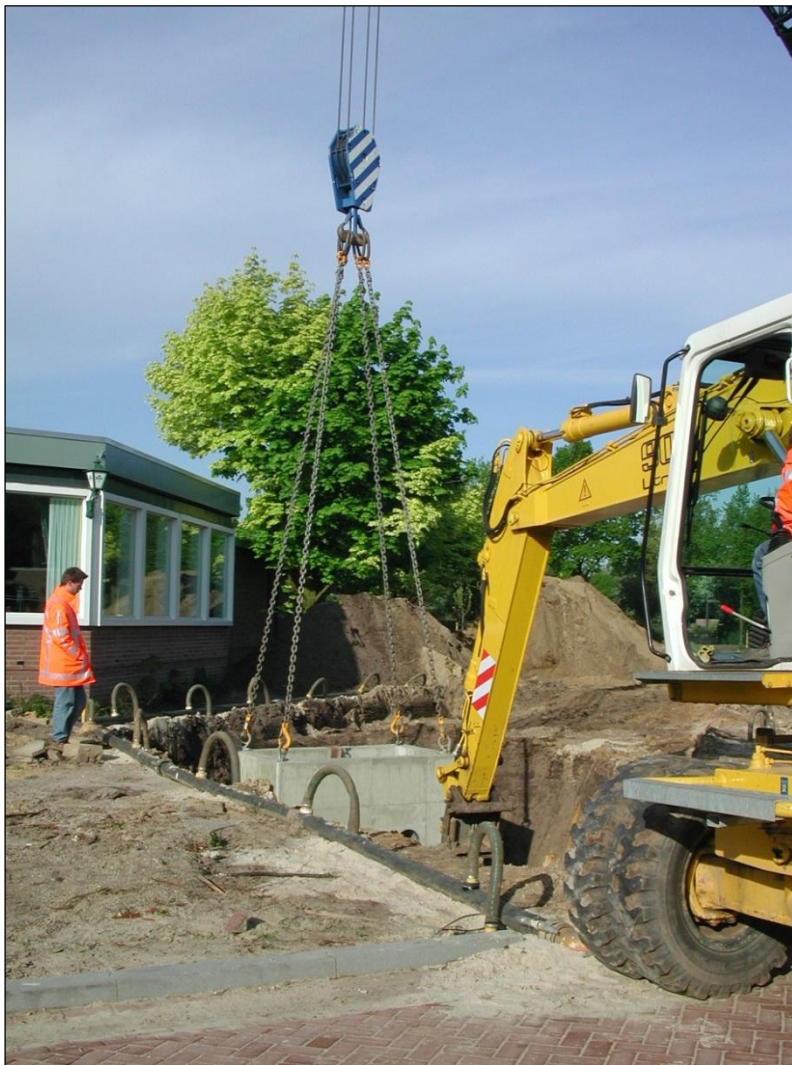
Afbeelding 4: Plaatsen regenwaterafvoer gemaal centrum Boekel
