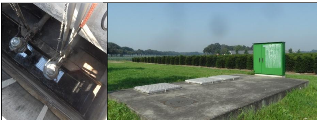
Afbeelding 14: Bergbezinkvoorziening gemengd rioelstelsel
