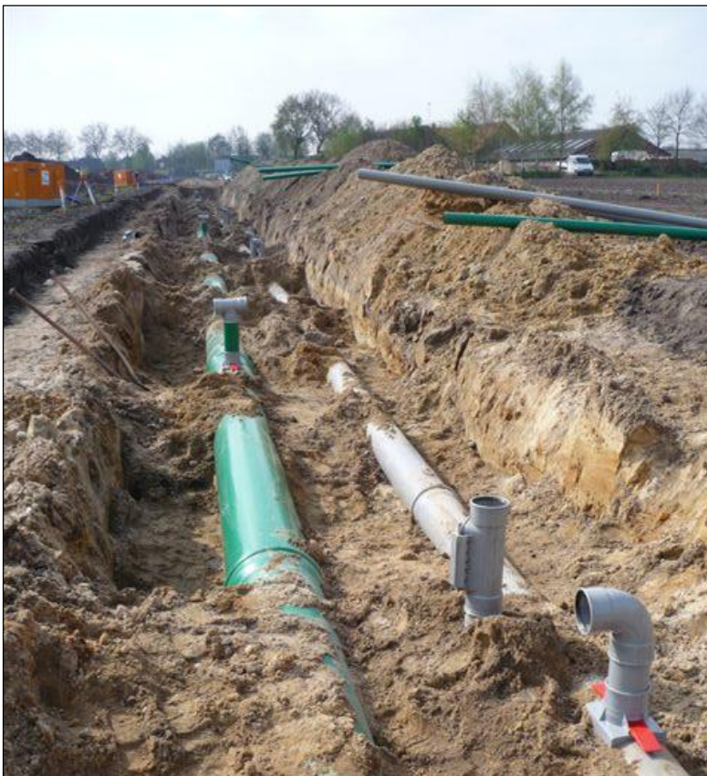
Afbeelding 15: Aanleg gescheiden riool De Donk
