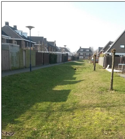
Afbeelding 3: Wadi de Donk (hemelwaterzorgplicht)
