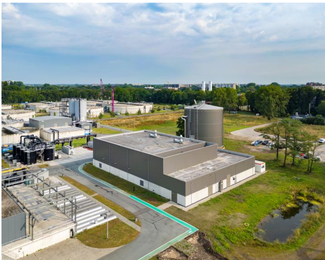
Figuur 4.17 Aquathermie Rioolwaterzuivering Utrecht (bron: Eneco https://www.eneco.nl/over-ons/wat-we-doen/duurzame-bronnen/warmte/warmtepomp-rwzi-utrecht/ )
