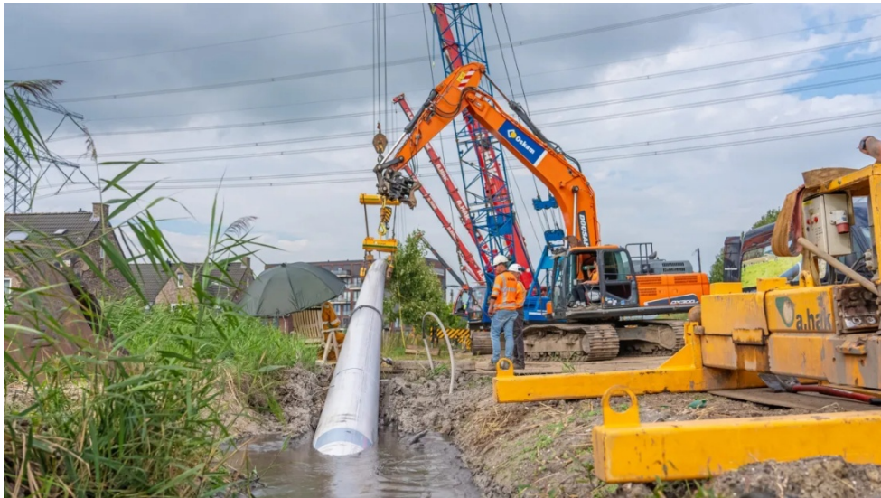
Figuur 4.15 Boring onder de Merwede door HVC, Drechtsteden (bron: HVC Groep )HVC Groep)
