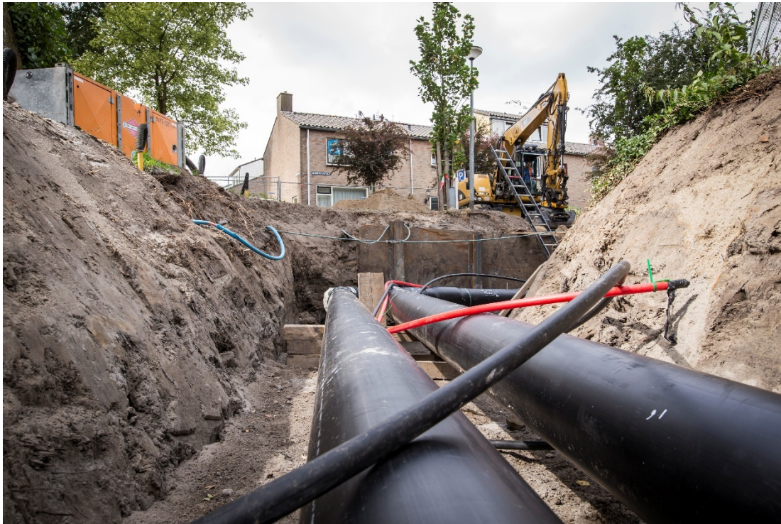
Figuur 4.2 Weergave van de ondergrondse buizen die worden aangelegd voor een warmtenet. (bron: https://www.duurzaambouwloket.nl/maatregel/warmtenet )
