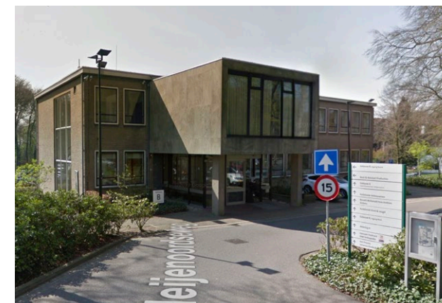
4. Heijenoordseweg 5 | In 1985 is de Heijenoordseweg 5 ontwikkeld. Het gebouw heeft door de tijd meerdere aanpassingen en uitbreidingen gehad.
