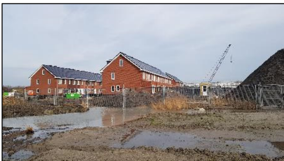
Foto 1: Nieuwbouwwoningen met nog te ontwikkelen braakliggende grond.
