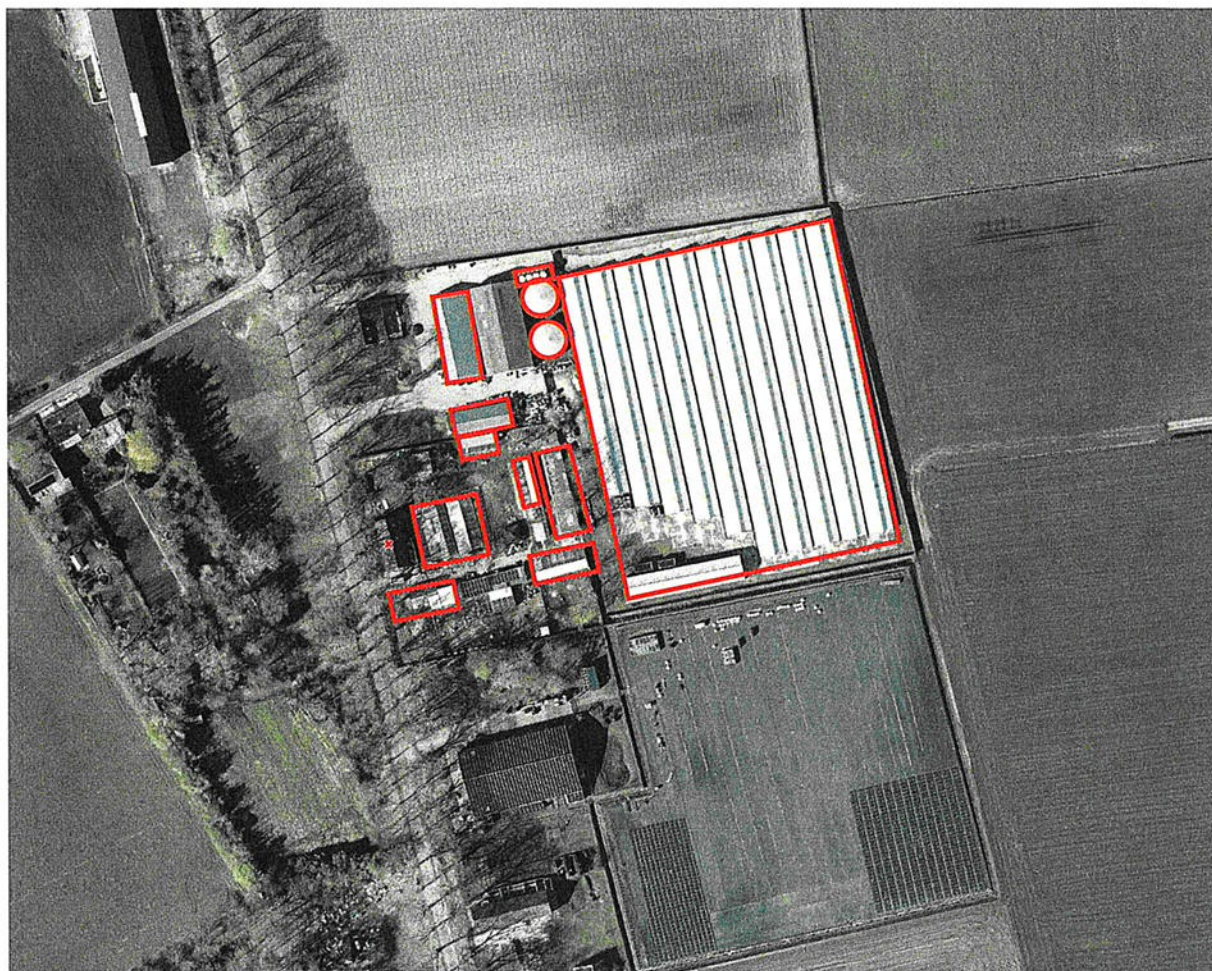
Figuur 3 Te saneren gebouwen Hoekstraat
