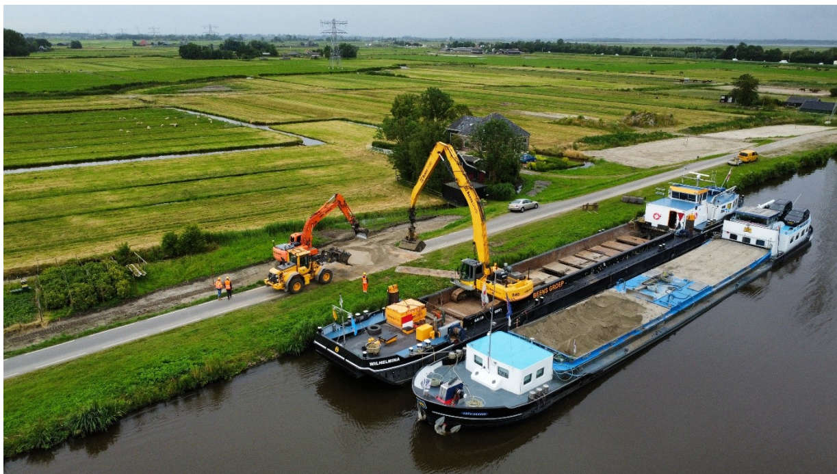
Aanvoer van zand voor versterking binnenwaartse stabiliteit bij VBK-project Starnmeer
