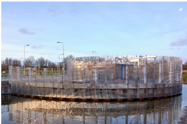
Ingebruikname van het nieuwe gemaal De Waardse Dijk, foto Harry Schuitemaker
