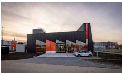
Warmtecentrale WarmteStad in Groningen
