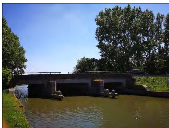
Foto 4: Brug N233 over watergang "Zijde"
