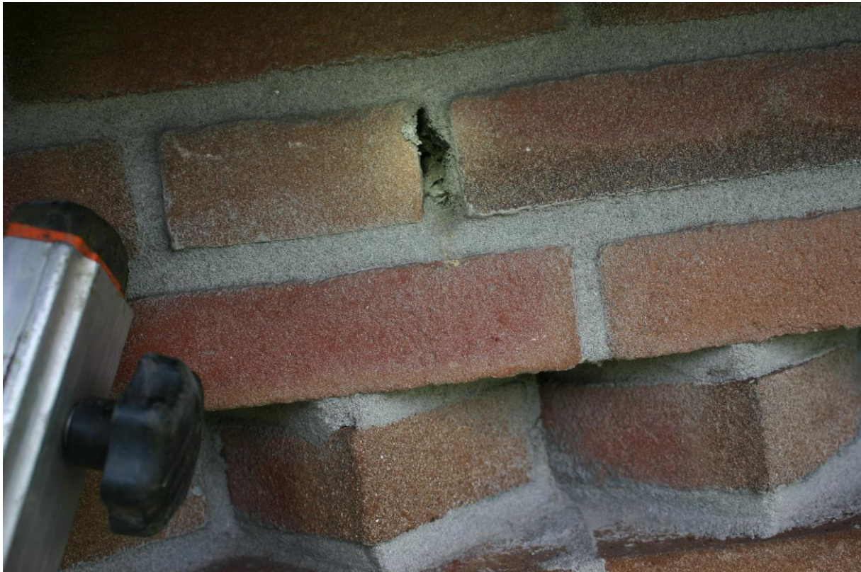
Figuur 4.2.1. Met spinnenrag gevulde open stootvoeg.
