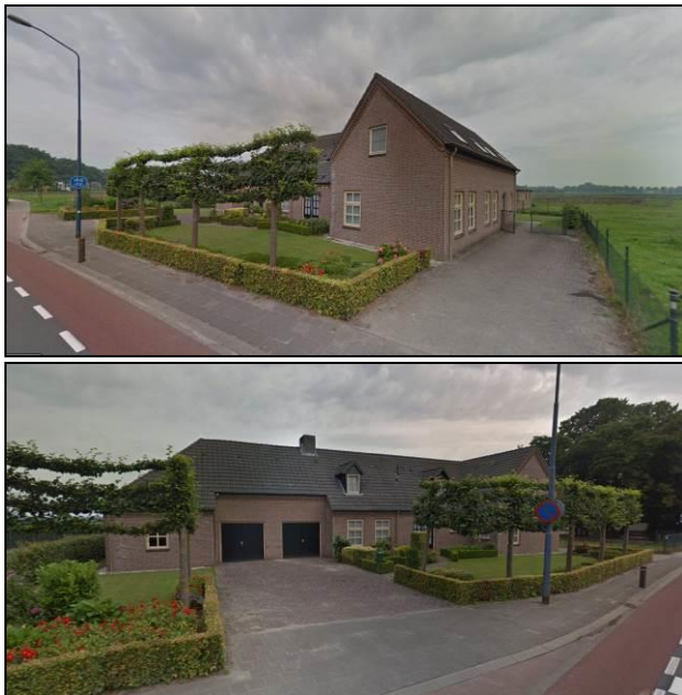
Figuur 3: Foto's bestaande situatie
