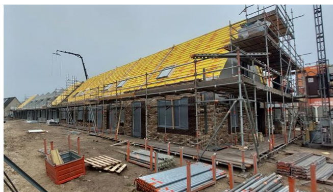
WEIDEKERVEL - Foto genomen d.d. 29/03/22 vanaf Heggewikke 2. Bouw van 12 woningen is in volle gang (foto is eigendom van de gemeente Duiven).
