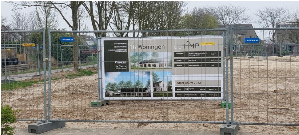
Foto genomen (d.d. 29/03/22) vanaf Walcherenstraat 64. Het terrein is vrij van opstallen. Foto is eigendom van de gemeente Duiven
