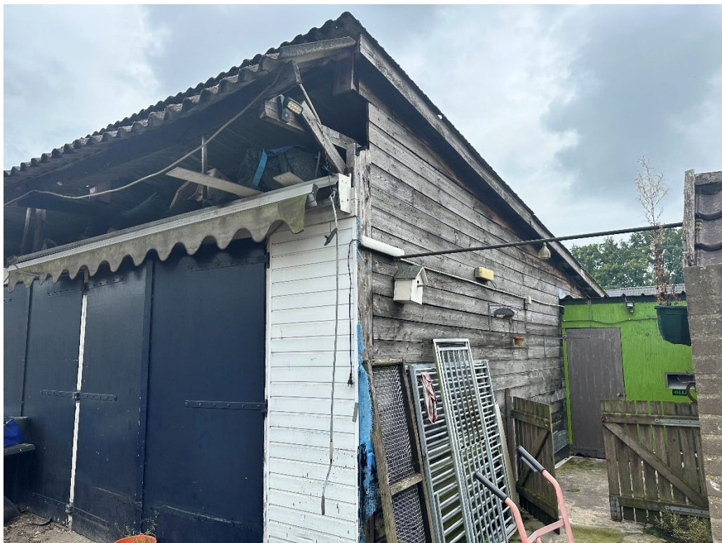
• Afbeelding 4: Voorzijde bijgebouw, mogelijk blijft een deel behouden
