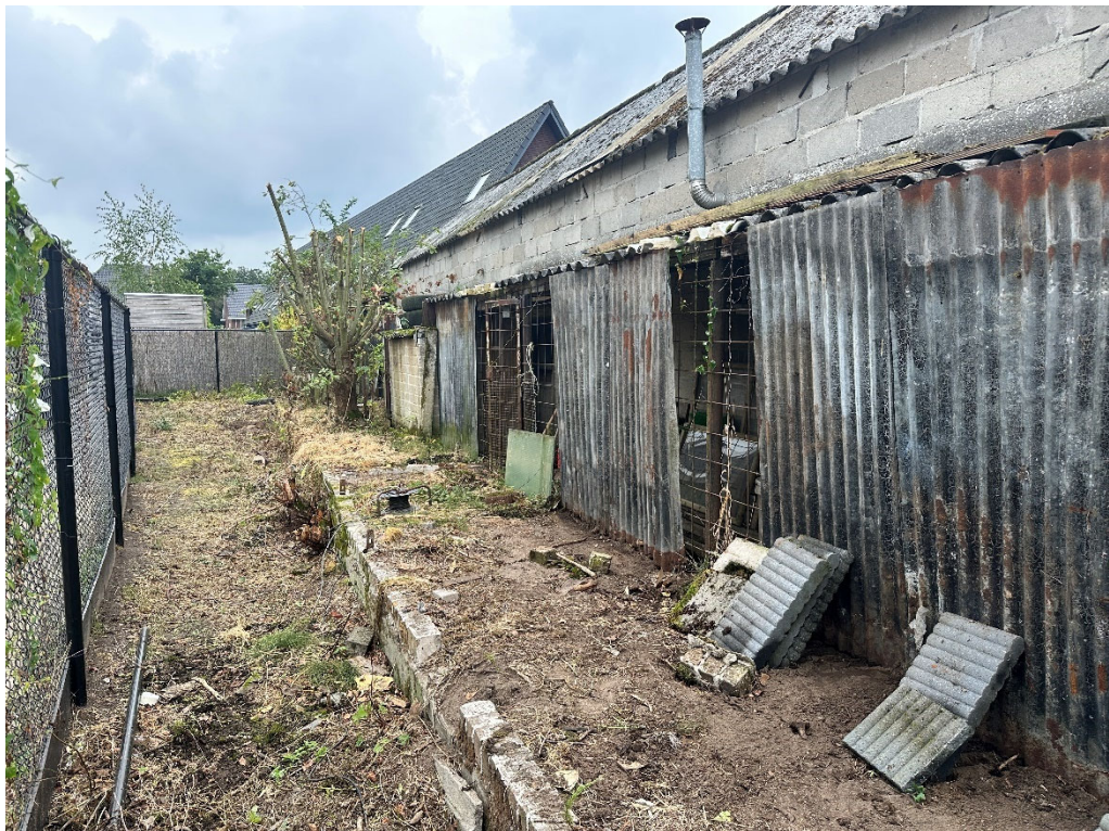
• Afbeelding 12: aangezicht achterste bijgebouw
