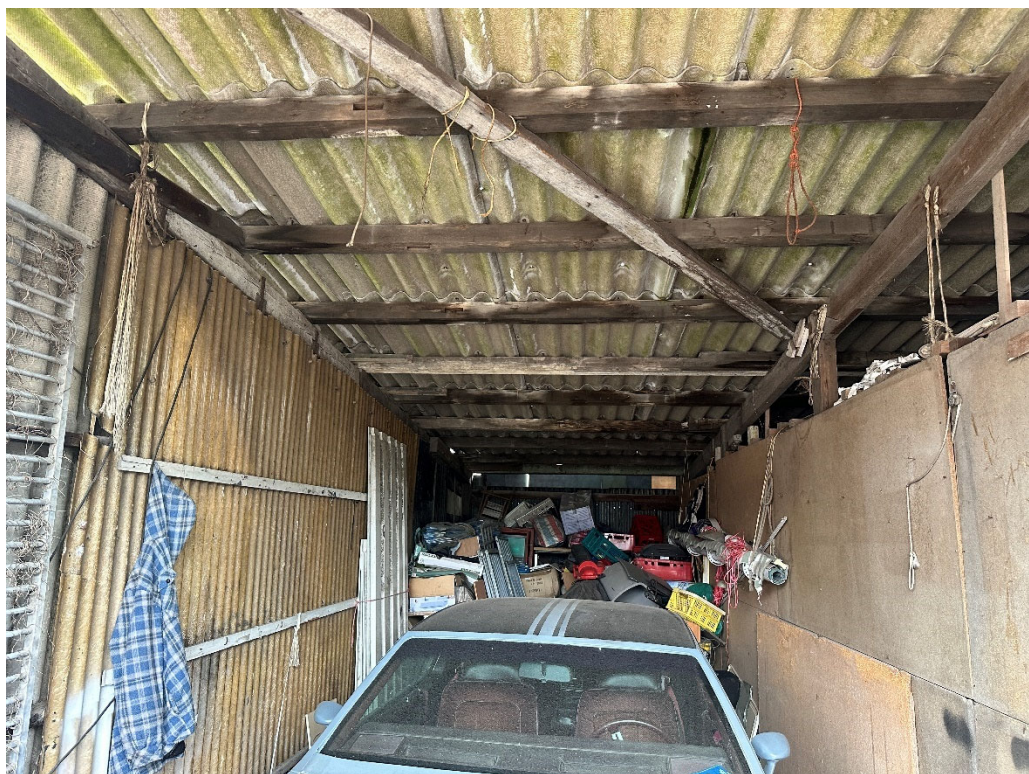
• Afbeelding 6: Binnenzijde bijgebouw en onderzijde dak
