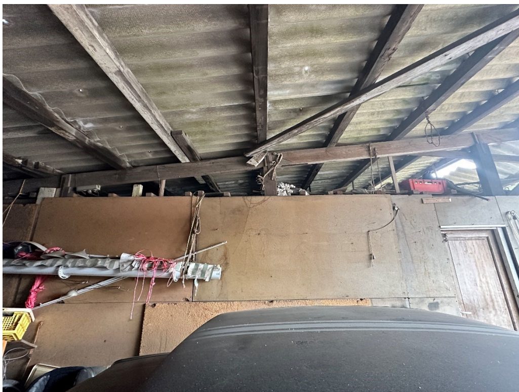
• Afbeelding 7: Onderzijde dak
