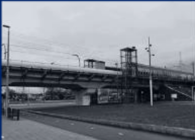
Huidige situatie vanaf de Noord-Oostelijke stationstrap kijkend richting de P+R
