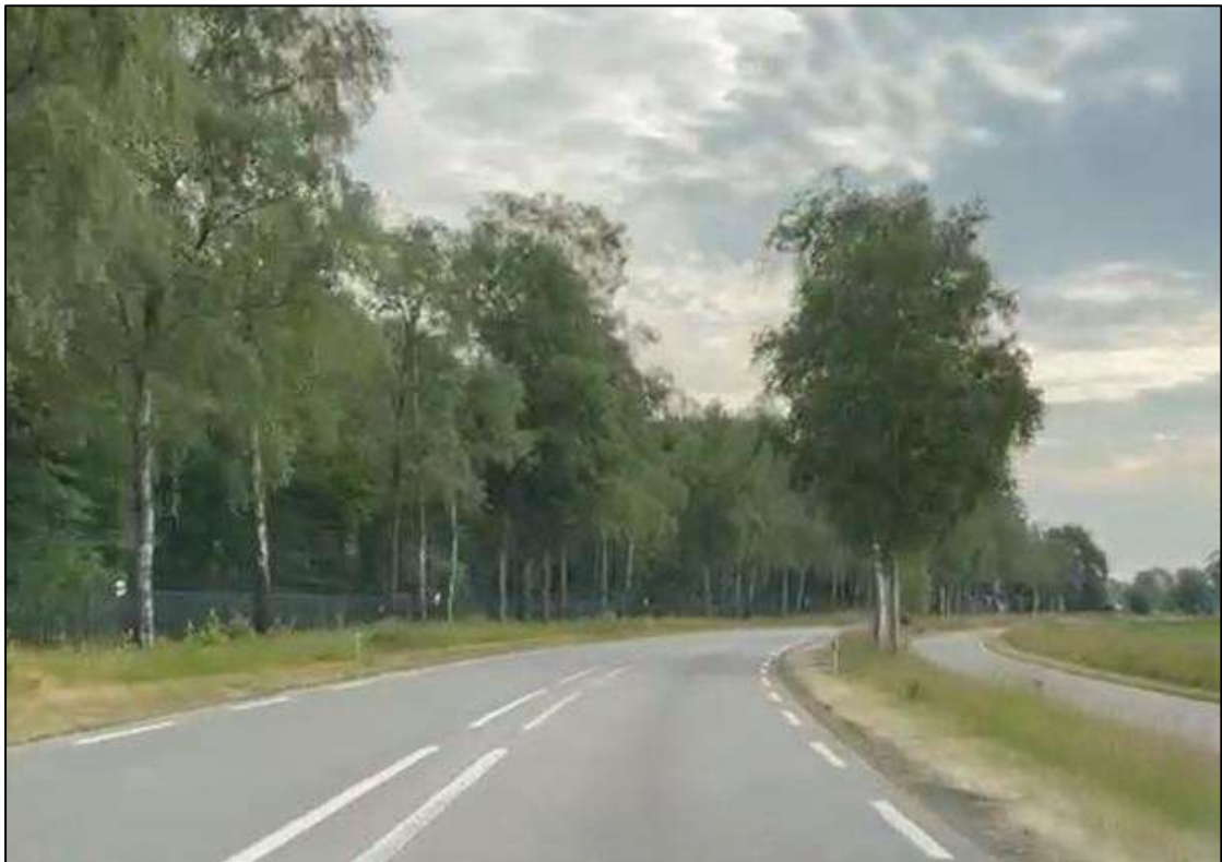
Afbeelding 38: Foto met zicht op N264,36 (Odiliapeel – St.-Hubert) ter hoogte van hectometerpaal 33,7.
