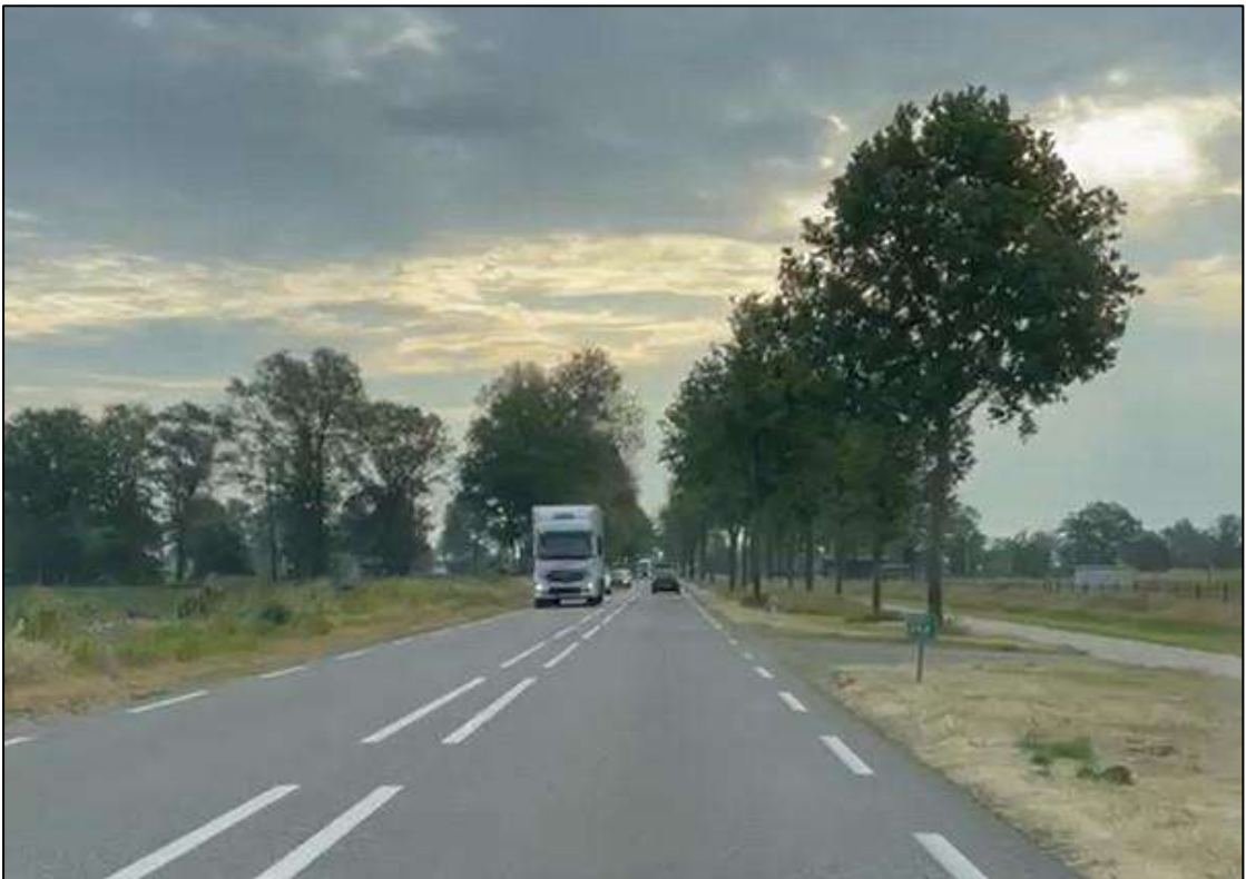
Afbeelding 40: Foto met zicht op N264,36 (Odiliapeel – St.-Hubert) ter hoogte van hectometerpaal 34,5.
