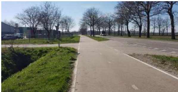
Figuur 5: Wegprofiel van de N264 binnen deelgebied 1, gezien vanaf het kruipunt met de N277.
