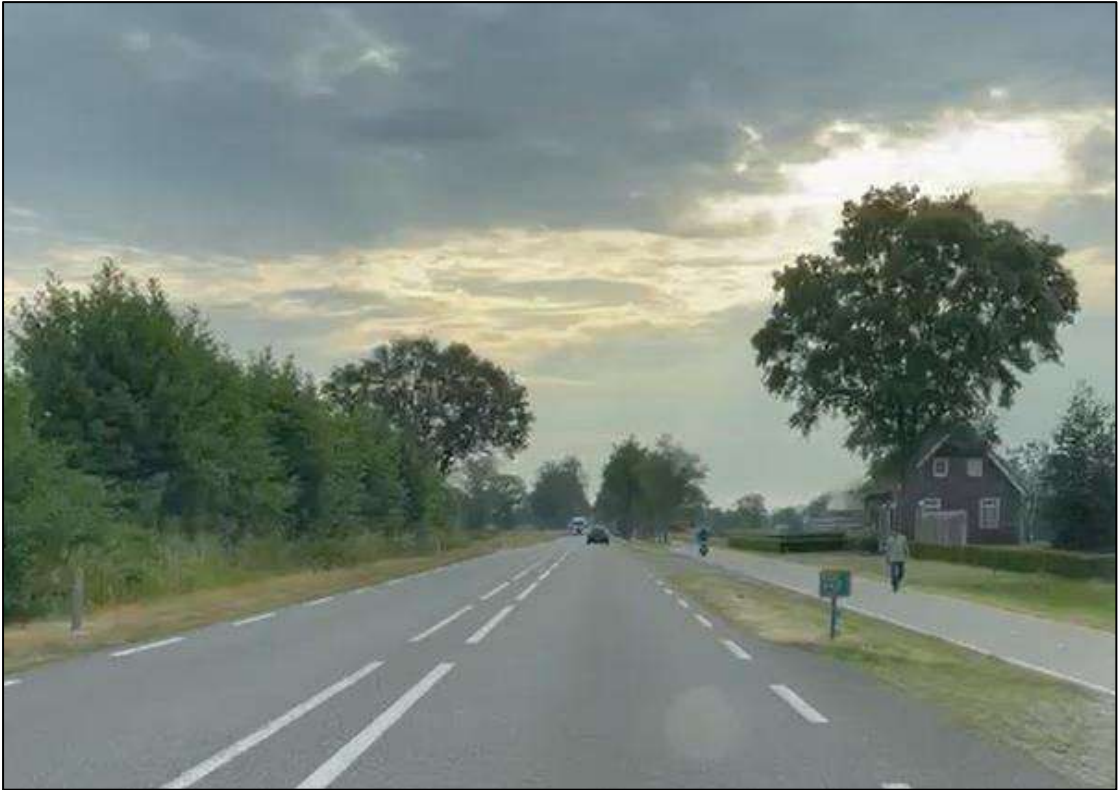
Afbeelding 39: Foto met zicht op N264,36 (Odiliapeel – St.-Hubert) ter hoogte van hectometerpaal 34,2.
