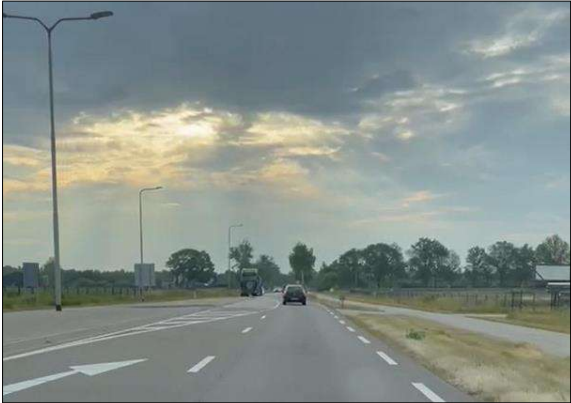
Afbeelding 37: Foto met zicht op N264.36 (Odiliapeel – St.-Hubert) ter hoogte van hectometerpaal 31,6.
