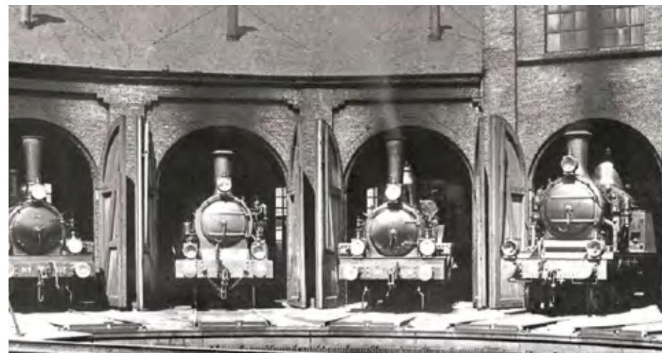
Locomotiefwerkplaats, gebouw jaren 1880.
